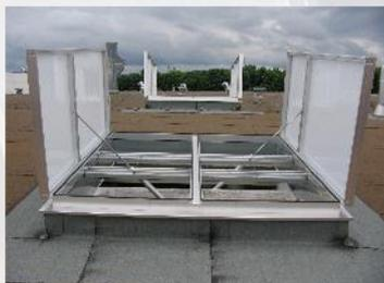
Quando dalla stazione di comando si invia il segnale di apertura, i battenti ruotano sulle cerniere in inox e si aprono a 90°, sia per l'evacuazione di fumo e calore che per la ventilazione naturale. In questo secondo caso l'apertura completa della bocca dell'apparecchio consente la migliore ventilazione possibile.
