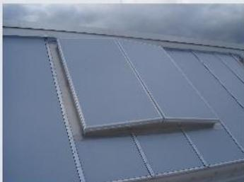
Quando dalla stazione di comando si invia il segnale di apertura, i battenti ruotano sulle cerniere in inox e si aprono a 90°, sia per l'evacuazione di fumo e calore che per la ventilazione naturale. L'apertura completa della bocca dell'apparecchio consente la migliore ventilazione possibile.
